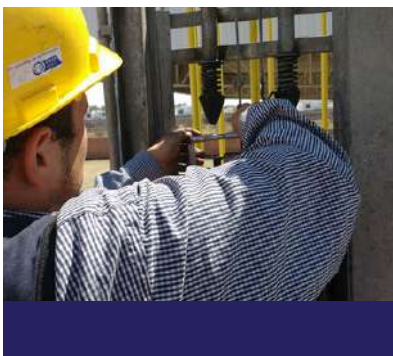
Limpieza de maquinaria y equipos
