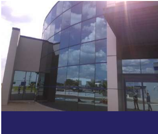
Limpieza de vidrios o cristales en alturas
